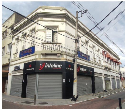
Figura 1 - Foto da fachada do imóvel.
