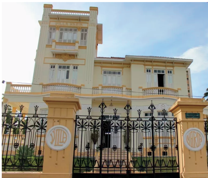
Figura 1 - Fachada do imóvel.
