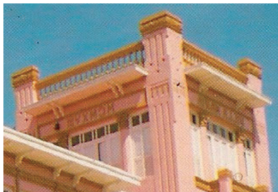
Figura 13 - Detalhe da torre
