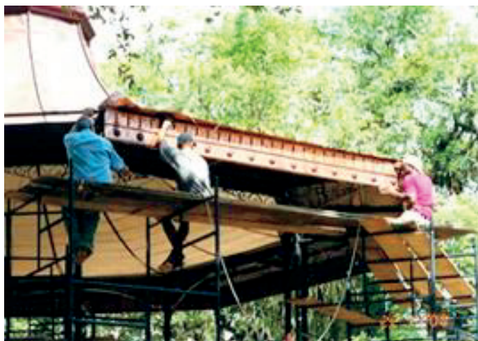
Figura 4 - Processo de reforma
