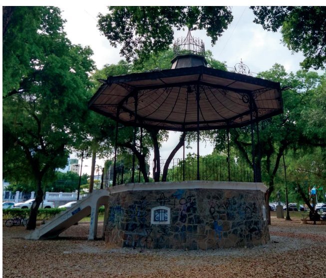
Figura 5 - Estado de conservação em 2023
